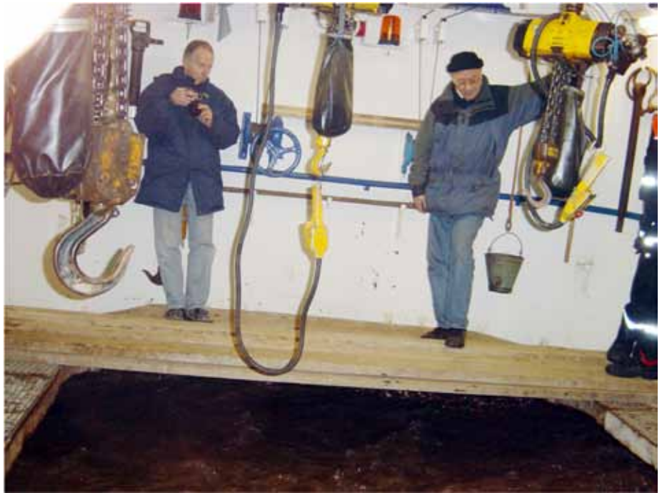
Abbildung 7: Die Tauchglocke ist für alle möglichen Arbeiten unter Wasser ausgerüstet; zur Ausrüstung gehören Anschlüsse für Druckluftgeräte (Presslufthammer), mehrere Hubwinden unterschiedlicher Stärke, Elektroanschlüsse zum Schweißen und noch weitere Einrichtungen. Zu den Aufgabenstellungen gehört das Suchen und Bergen von Hindernissen auf der Flusssohle, z. B. das Bergen von Containern, die bei einer Havarie - einem Schiffsunfall - in den Fluss gefallen sind, Entnahme von Bodenproben der Flusssohlen, Bauwerksprüfung von Schleusen und Wehren sowie die Kontrolle der Verankerungen der Fahrwassertonnen und evtl. Setzen von neuen Verankerungen (Bild Siegmann 2006).
